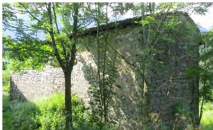
Le pietre d'angolo, solitamente molto più grosse, sono disposte a "pettine alterno", e là dove si è provveduto ad intonacare l'edificio queste sono state lasciate a vista. Negli staveli resiani sono sporgenti.
